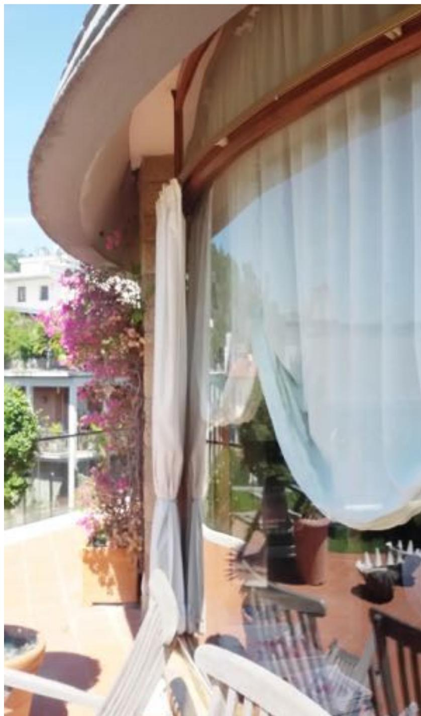
Palazzine in via dei Colli della Farnesina, dettaglio d'attacco tra la cappa del tetto e i sopraaluce. Si noti il binario appositamente realizzato per ancorare le tende esterne.
