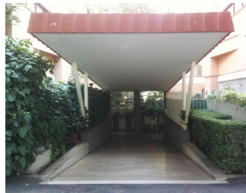
Palazzine di via Montanelli, pensilina d'accesso in cemento armato sorretta da pilastri a "V" in ferro bianco e rivestita da una guaina ardesiata rossa e ondulata.
